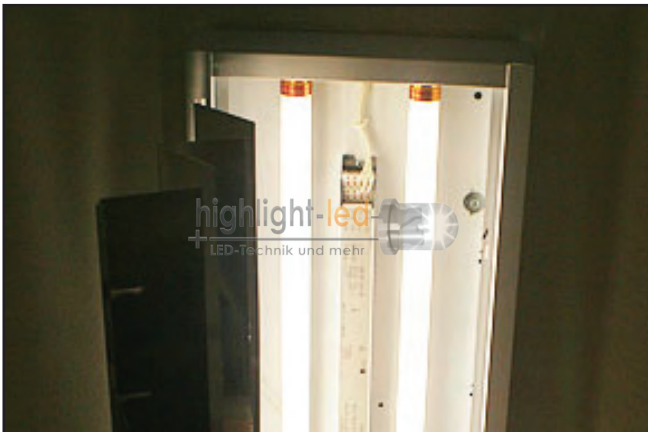
Nachdem die Stromzufuhr wieder hergestellt wurde, kann nun ein Funktionstest erfolgen und die Abdeckung wieder befestigt werden. Dies war nun auch der letzte Schritt. Wir wünschen Ihnen viel Spaß mit den neuen LED-Röhren.
