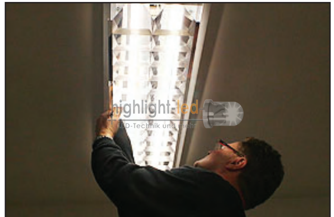
Nachdem die Stromzufuhr wieder hergestellt wurde, kann nun ein Funktionstest erfolgen und die Abdeckung wieder befestigt werden. Dies war nun auch der letzte Schritt. Wir wünschen Ihnen viel Spaß mit den neuen LED-Röhren.
