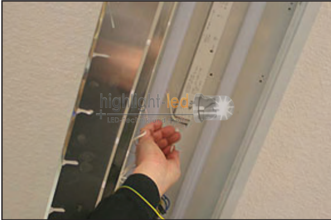
Das elektronische Vorschaltgerät wird nun abgeklemmt.
